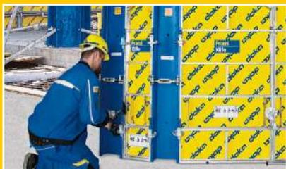
La sólida construcción y la disposición asimétrica de los anclajes permiten una completa presión hidrostática del hormigón en elementos de 270 cm de altura.
