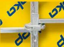
Los elementos universales Frami Xlife permiten realizar esquinas en ángulo recto con un espesor máximo del muro de 60 cm dentro de la retícula de 5 cm.
