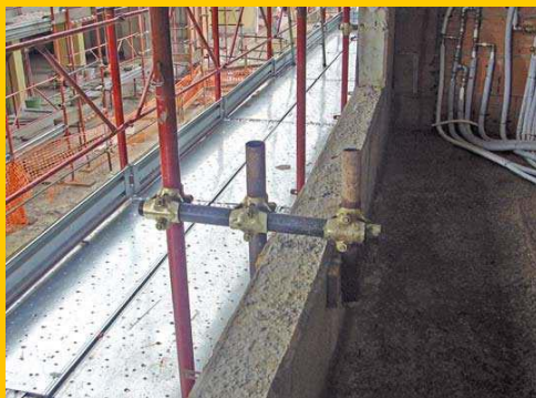
Anclaje por corbata, realizado sobre paredes
